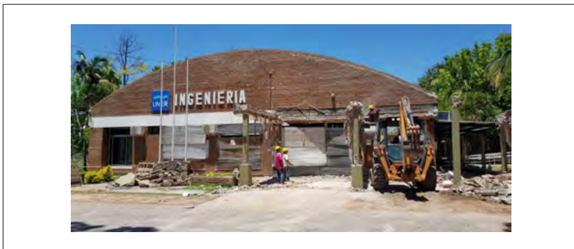
IMAGEN 3. Comienzo de la obra sobre la fachada original de la FI-UNER
