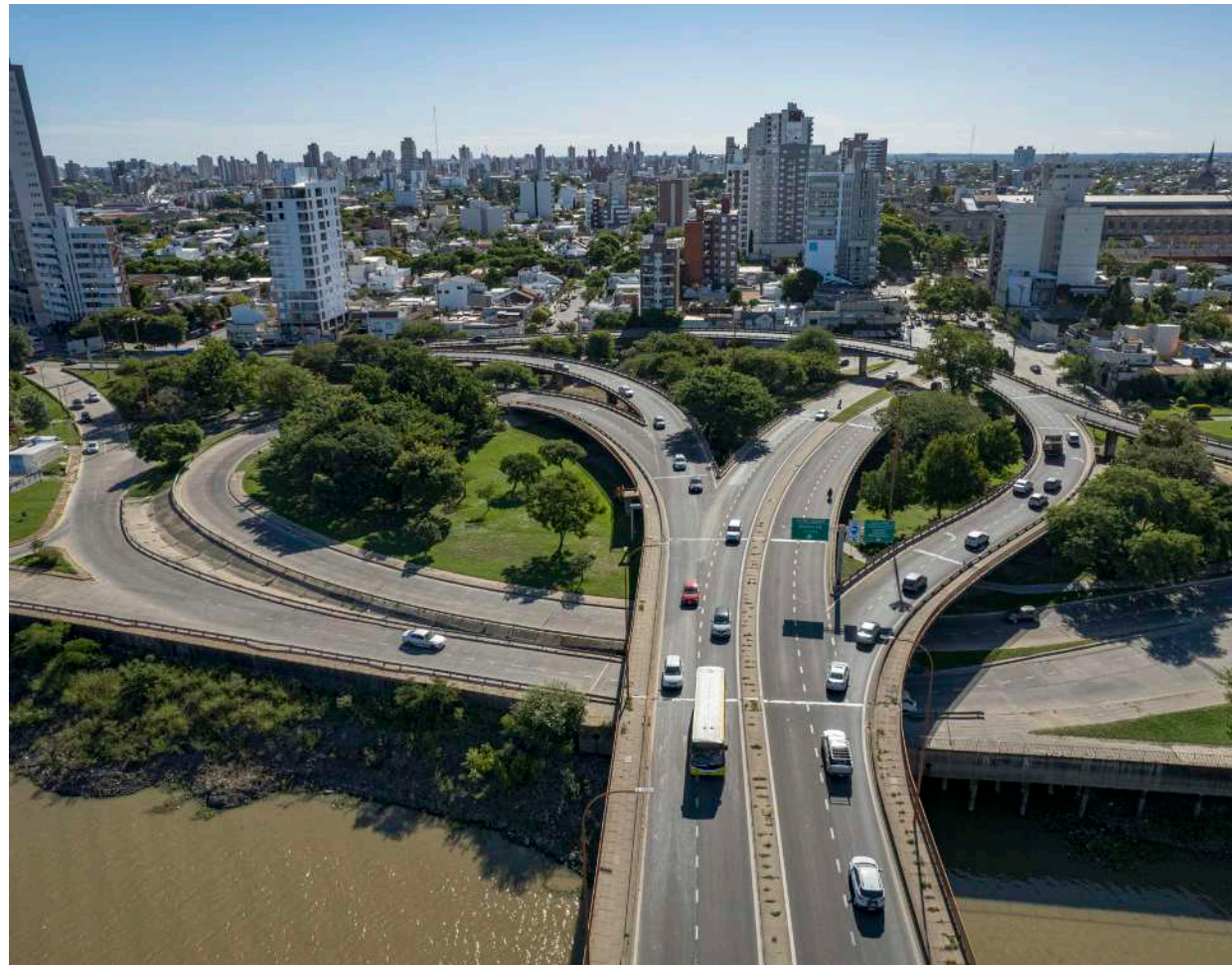
Vista aérea del acceso este a la ciudad. |
