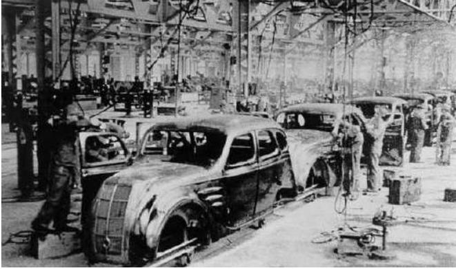
**Foto Cadena de Montaje de Toyota en 1938**
